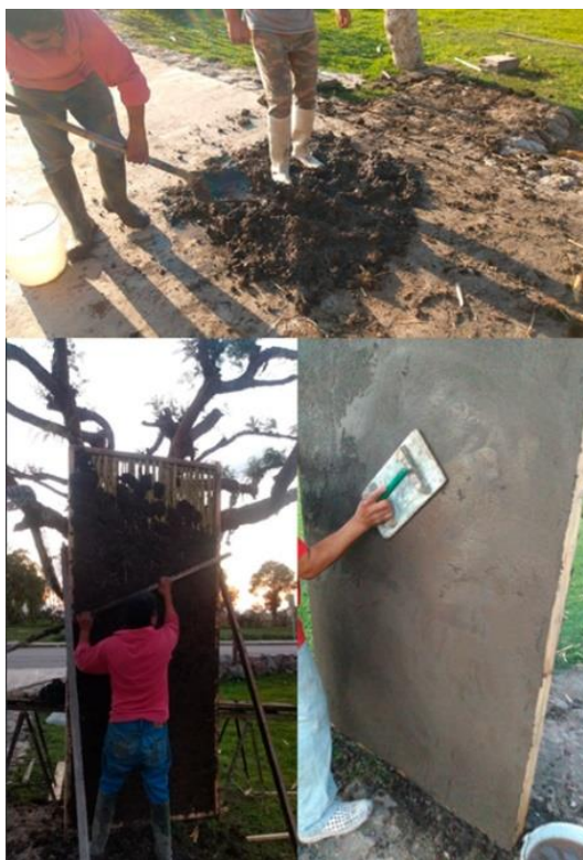
Figura 9 Proceso de preparación y colocación del mortero para los muros de bajareque. Fuente: Elaboración propia (2018).
